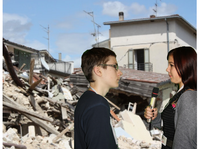
Das zerstörte Haus.
